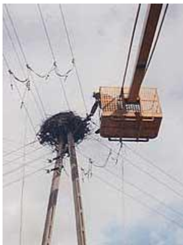
Przygotowania do założenia platformy na słupie energetycznym
