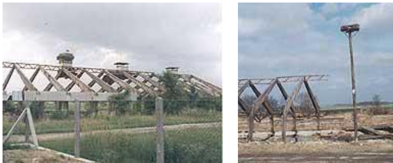
Zamiana gniazda umiejscowionego na starej hali przeznaczonej do rozbiórki na słup wolnostojący ustawiony w tym samym miejscu
