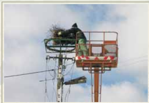
Układanie wyściółki. Fot. AT
