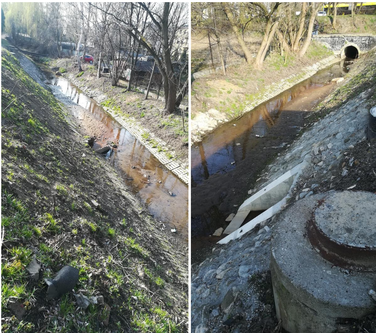
Fot. 4 Rzeka Kłodnica (miejsce wylotu)
