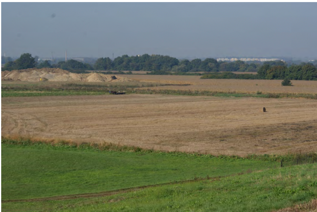
Fot 3 Widok na teren usytuowania wschodniego odcinka zapory czołowej, w miejscu jej łączenia z zaporą wschodnią
