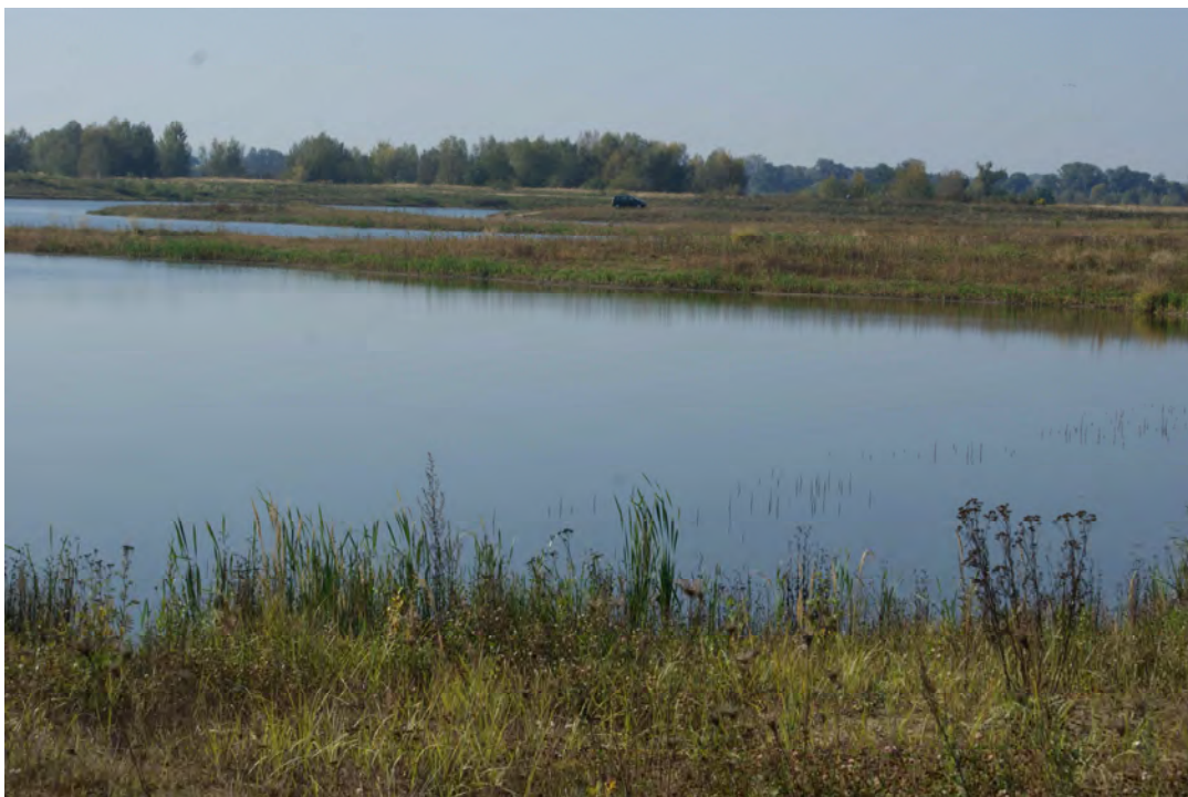
Fot 5 Poeksploatacyjne akweny wodne położone w bezpośrednim sąsiedztwie terenu lokalizacji zapory czołowej
