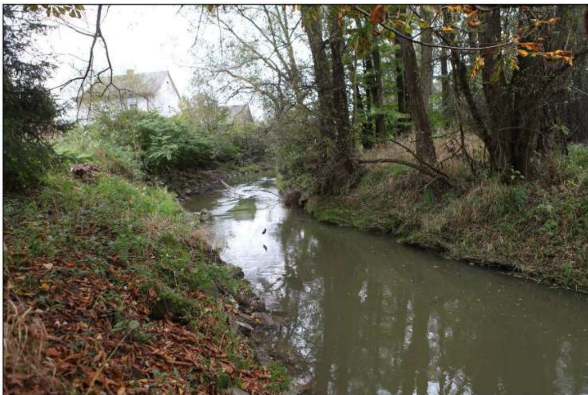
Częściowo wzmocniony lewy brzeg Piotrówki na północno-zachodniej części terenu, 20.10.2014 (RK)
