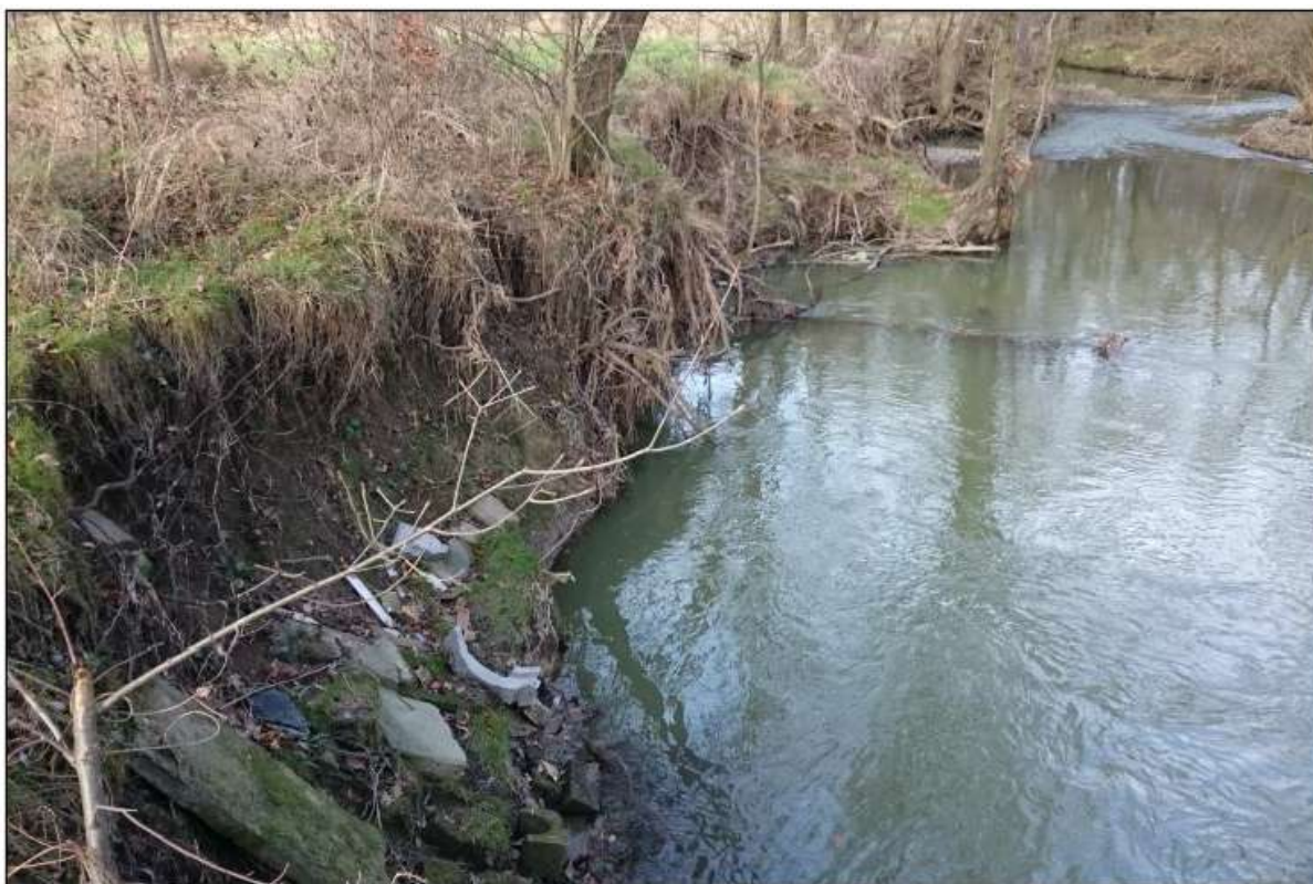
Brzeg Piotrówki przy powiązanej tamie na północno-wschodniej części terenu, 12.12.2014 (RK)
