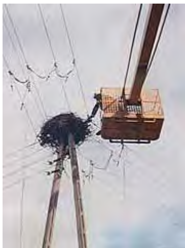
Przygotowania do założenia platformy na słupie energetycznym
