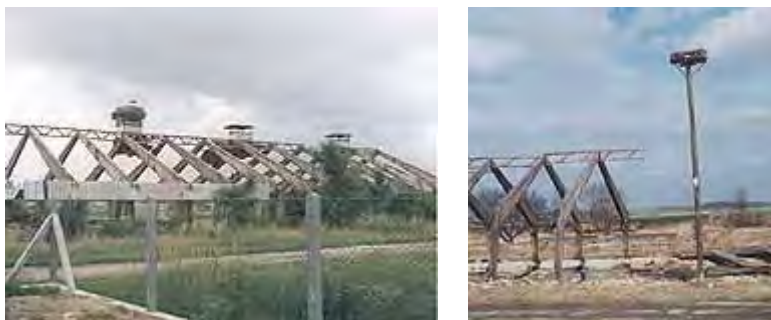
Zamiana gniazda umiejscowionego na starej hali przeznaczony do rozbiórki na słup wolnostojący ustawiony w tym samym miejscu
