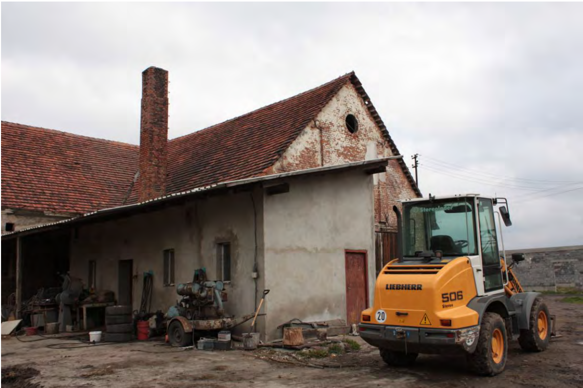
19.KYRY, GMINA SUSZEC-DACH
