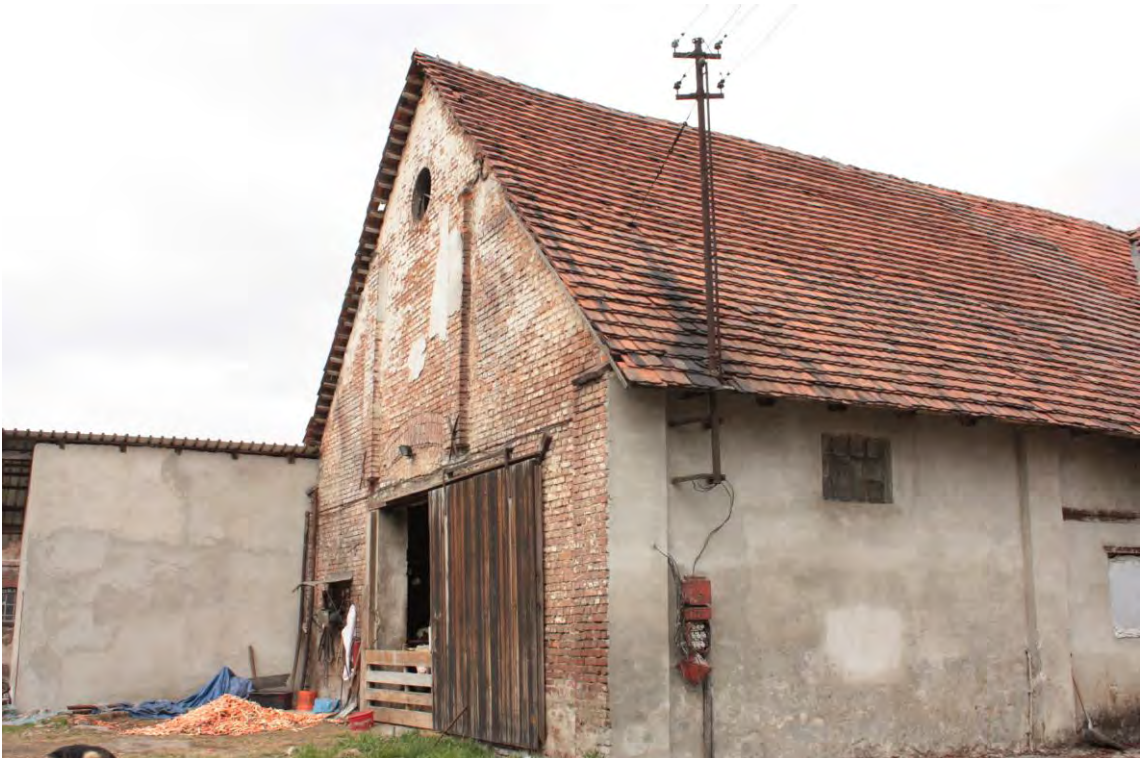
19.KYRY, GMINA SUSZEC-DACH
